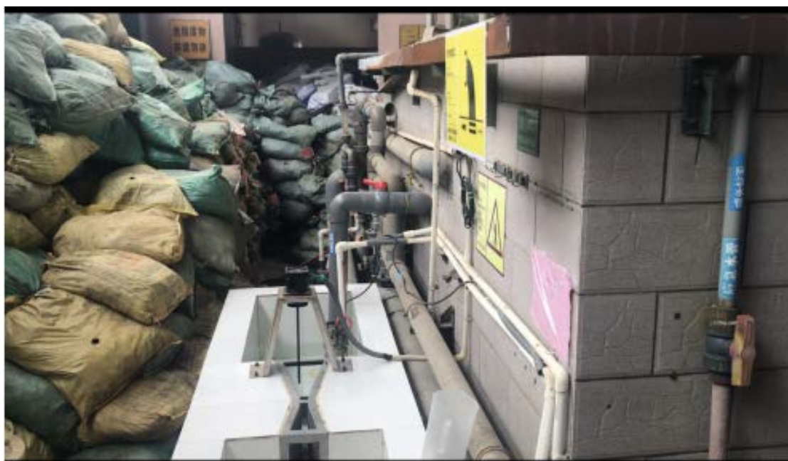
附件 6 一类排放口照片
