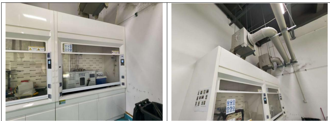
实验室通风橱废气收集
