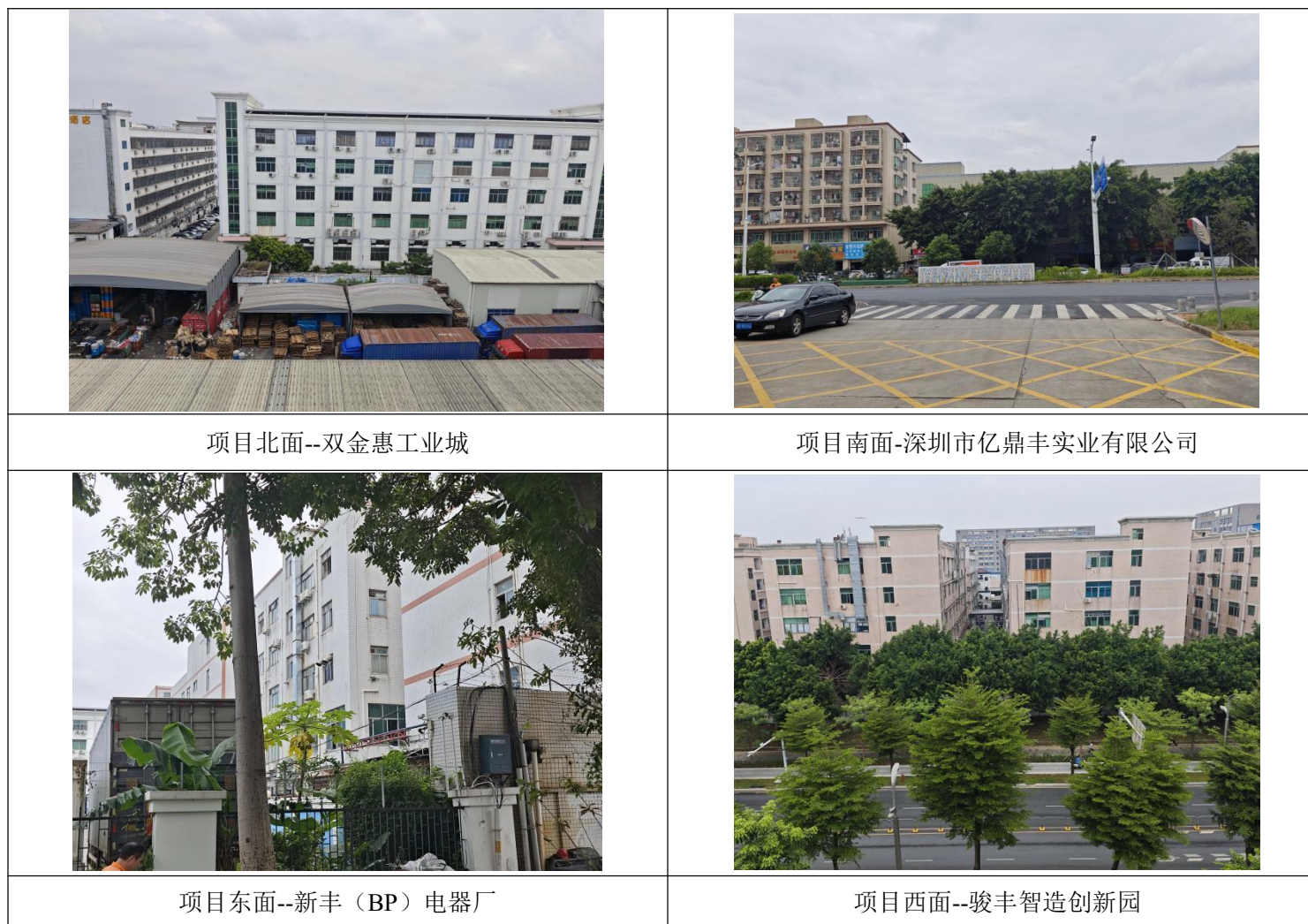
图 3.1-4 现有项目现状照片
